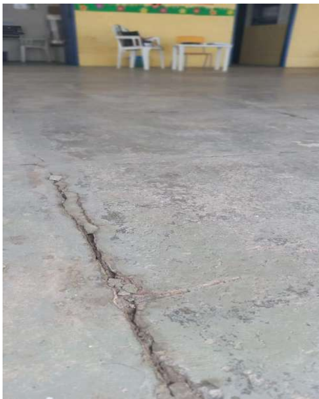
Foto 54. Piso do pátio soltando vidros
