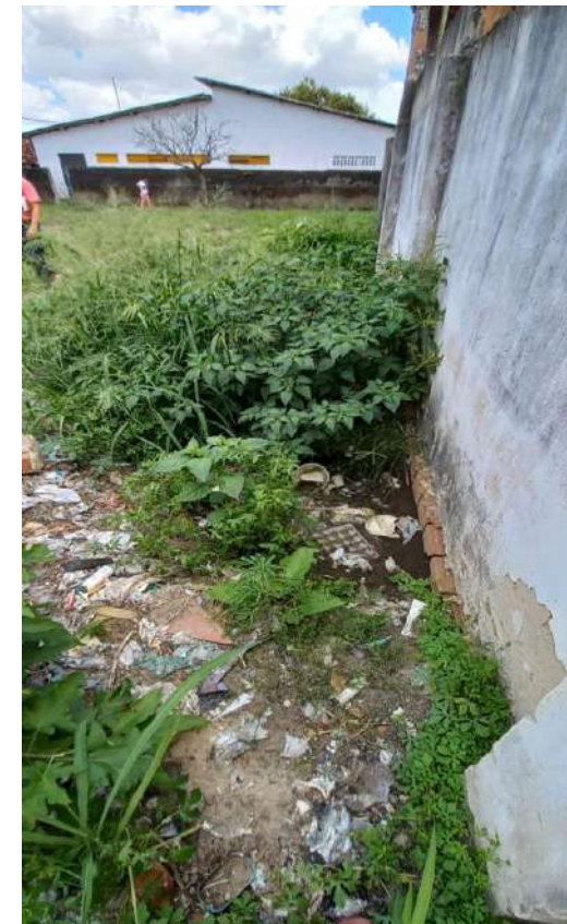
Foto 53. Esgoto à céu aberto
