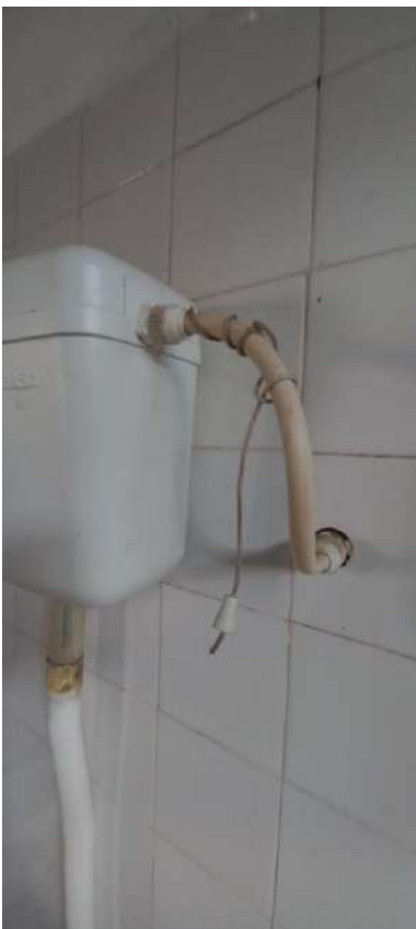
Foto 39. Descarga quebrada
