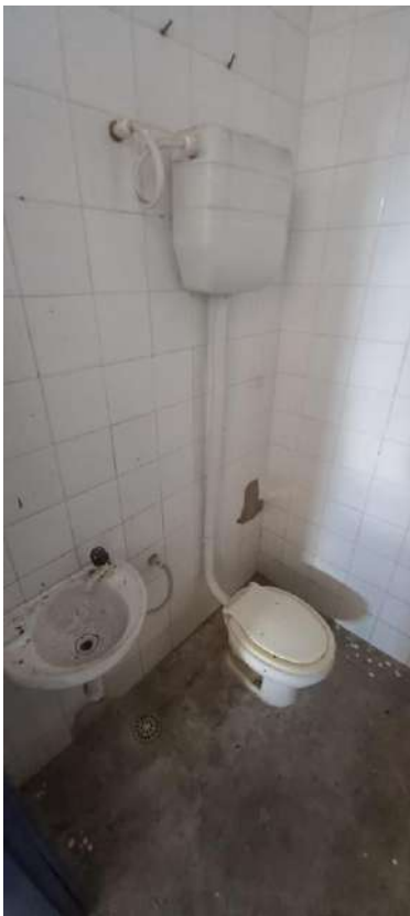
Foto 47. Descarga quebrada
