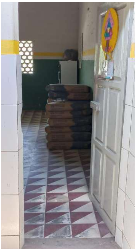
Foto 71. Porta de sala de aula estreita
