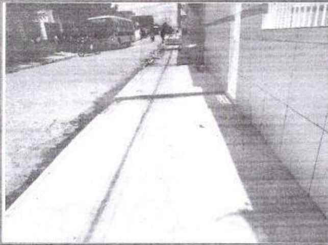
FOTO 09 – EXECUÇÃO DE PASSEIO (CALÇADA)
